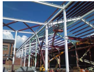
Aplicación pintura intumescente
