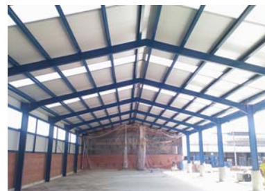
Aspecto final pintura intumescente
