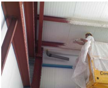
Aplicación mortero proyectado
