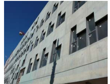
Aspecto final fachadas
