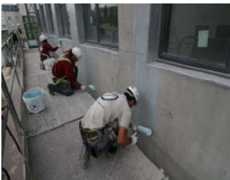
Ejecución de los trabajos
