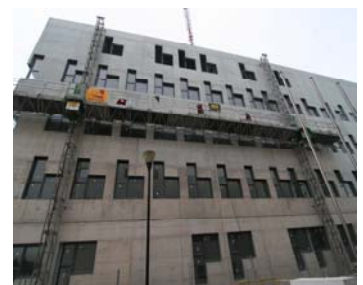
Ejecución de los trabajos
