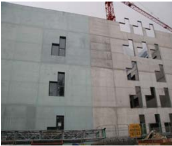
Ejecución de los trabajos
